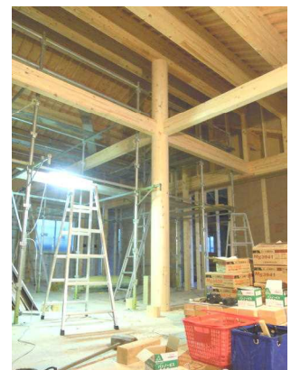
工事中の丸柱と化粧梁
