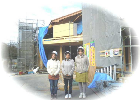
12/25 新園舎工事現場
